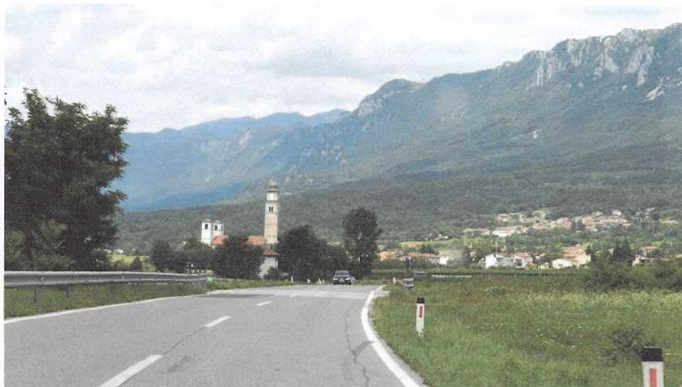
Slika 4: območje ceste v km 3+160
