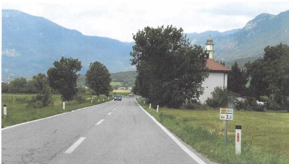
Slika 5: območje ceste v km 3+500
