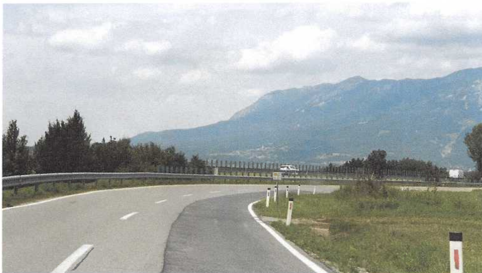
Slika 2: območje trase ceste v bližini hitre ceste H4/0387 - v km 2+500
